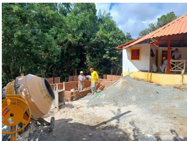
Rechts de Eco-Oca en links de nieuwbouw
