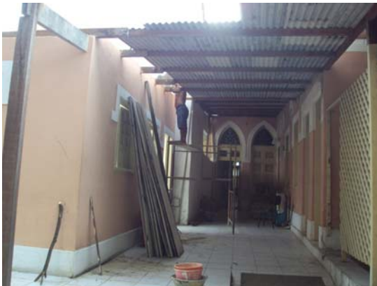
Een nieuwe dakbedekking voor de aanbouw
