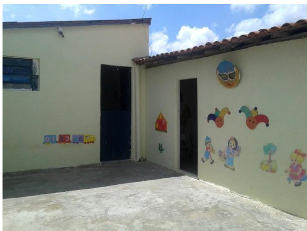
Prachtig binnenplaatsje met nieuw dak
