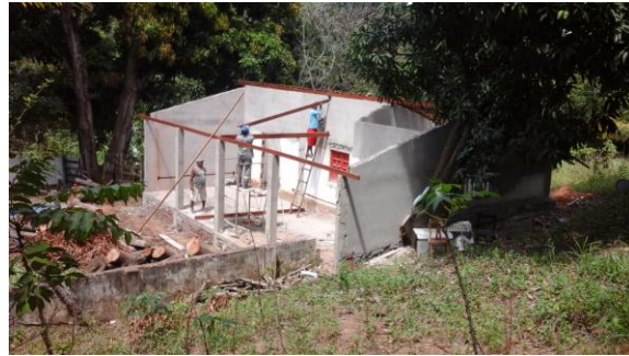
Het achterste huisje, in grootte verdubbeld. Het dak gaat erop!
